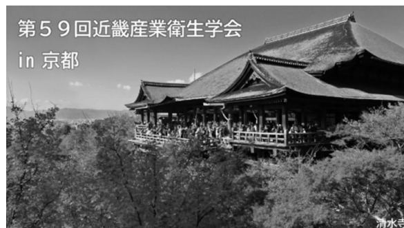
清水寺 (ただいま平成の大改修にて本堂屋根工事中 2020年3月完成予定)
