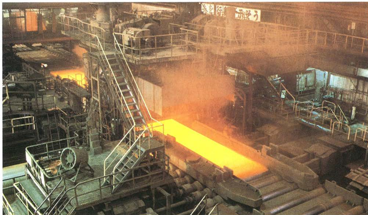
厚板圧延設備
